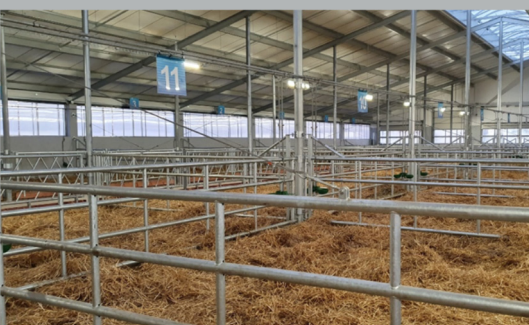
Die zu diesem Zeitpunkt erst 3 Wochen alte Anlage ist umzäunt, damit das unkontrollierte Eindringen von Tieren und Menschen verhindert werden kann und bietet Platz für 600 Tiere.
